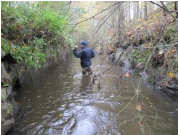
Kuva 26. Eräjärven vedenpinnan korkeutta säätelevää kalliokynnystä on louhittu aikoinaan ja toimilla on alennettu Eräjärven veden pinta nykyiselle tasolle. Joki on reilun sadan metrin matkalla hyvin kanavamainen.
